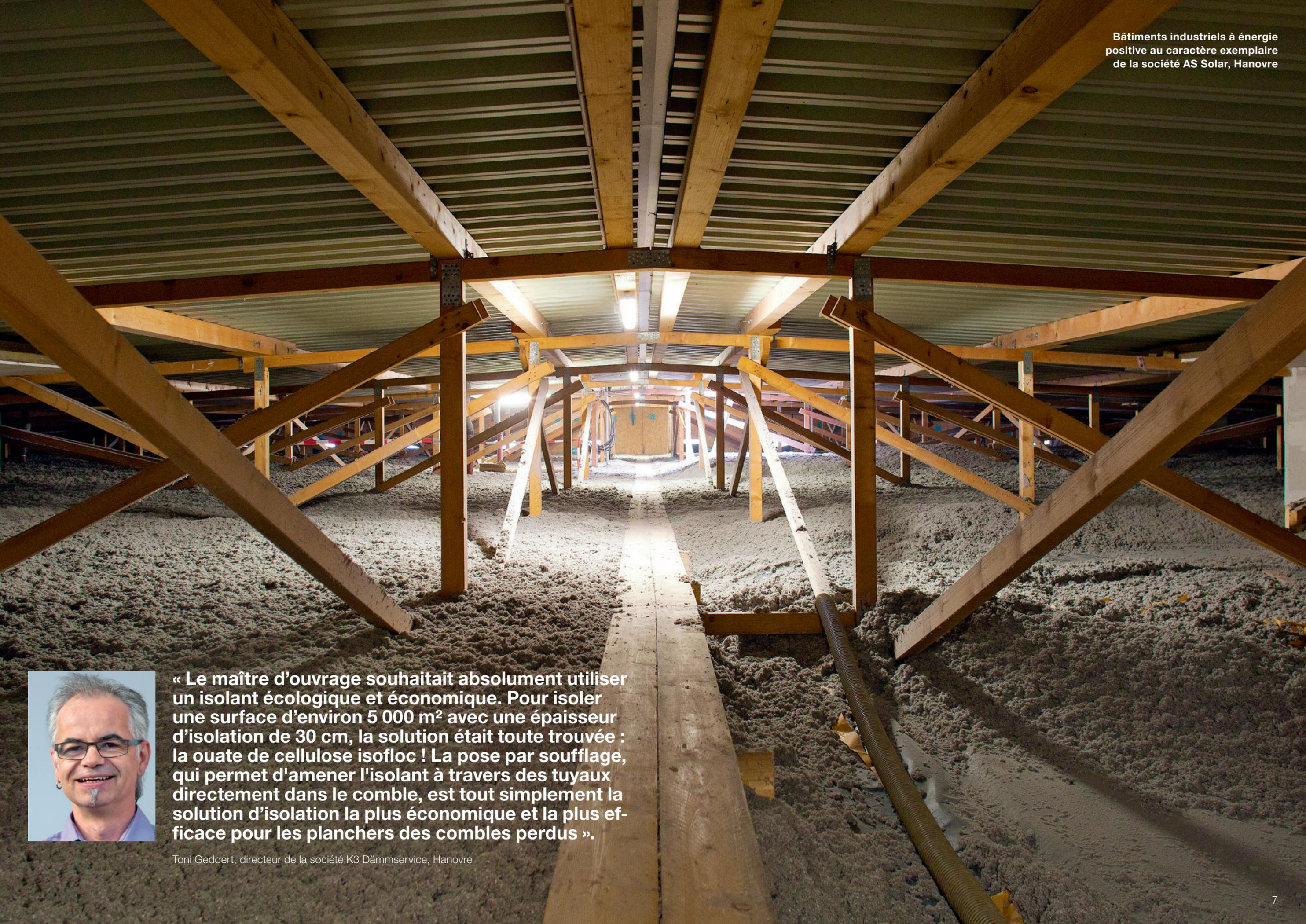
« Le maître d'ouvrage souhaitait absolument utiliser un isolant écologique et économique. Pour isoler une surface d'environ 5 000 m<sup>2</sup> avec une épaisseur d'isolation de 30 cm, la solution était toute trouvée : la ouate de cellulose isofloc ! La pose par soufflage, qui permet d'amener l'isolant à travers des tuyaux directement dans le comble, est tout simplement la solution d'isolation la plus économique et la plus efficace pour les planchers des combles perdus ».
